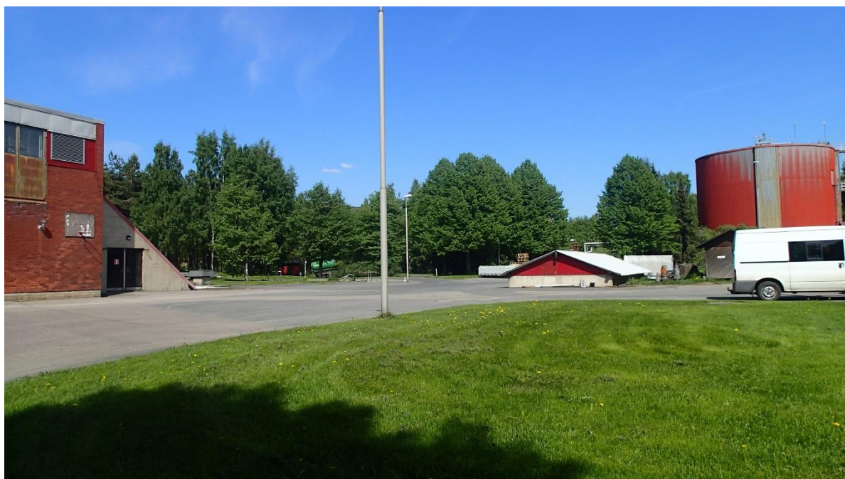
Kuva 2. Viinikanlahden vedenpuhdistamon rakennuksia ja puustoa.
